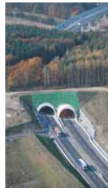
Dálniční tunel Valík, Stavba roku 2006 Plzeňského kraje.
